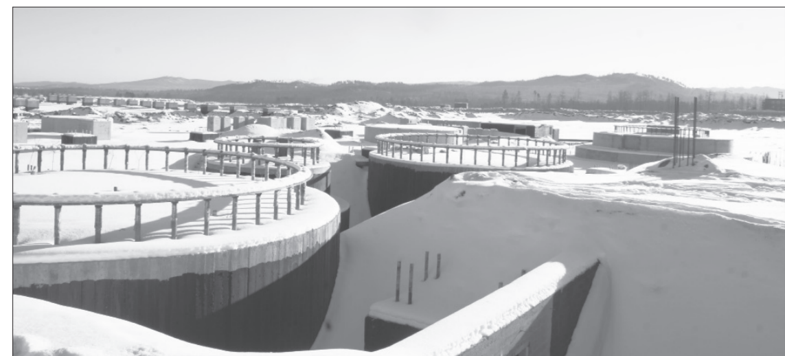
Фундамент ЦПК под основное производство целлюлозы уже готов. Осталось привезти из Австрии варочный котёл, для доставки которого инвестору так необходимо открытие перехода Покровка – Логух.
