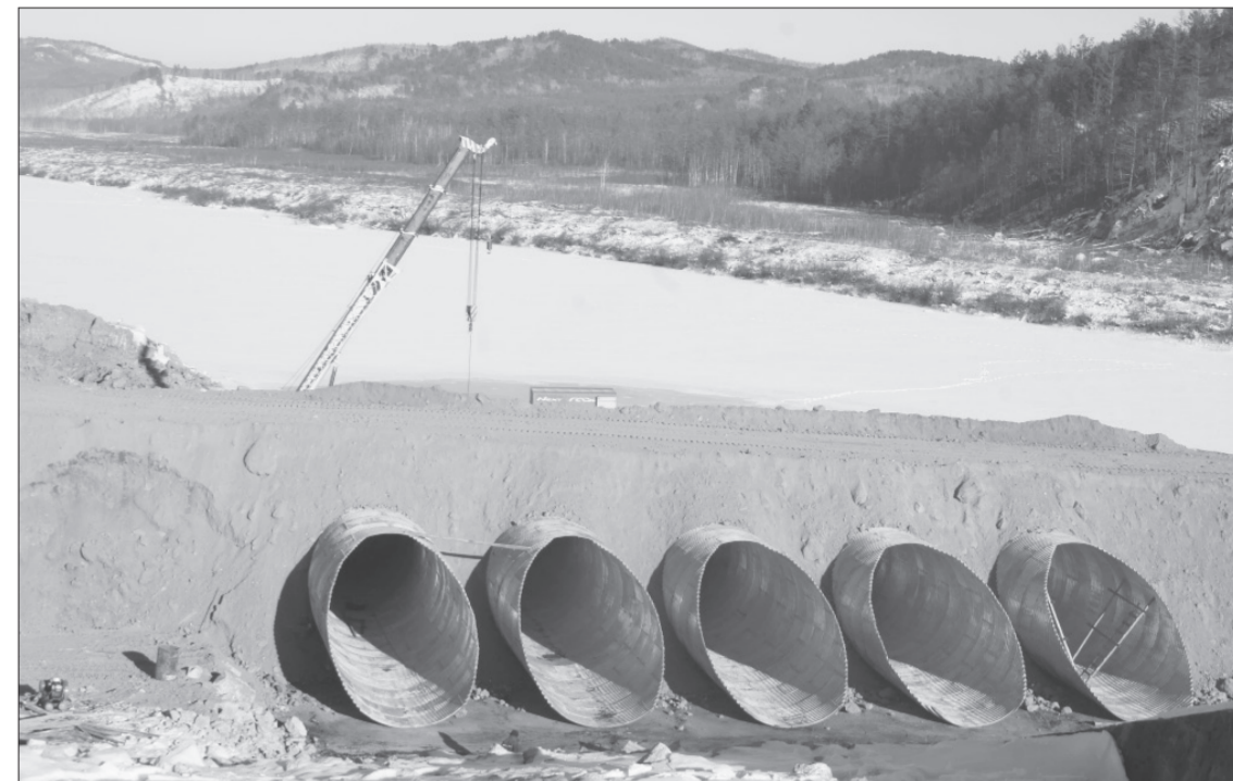
Строится плотина на реке Амазар, на которой уже созданы рыбохозяйственные сооружения. По словам Георгия Трифонова, такая технология применяется в Забайкалье впервые.
