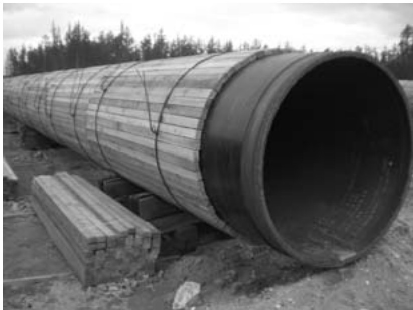
В таком виде труба будет уложена в траншею на дне Лены
