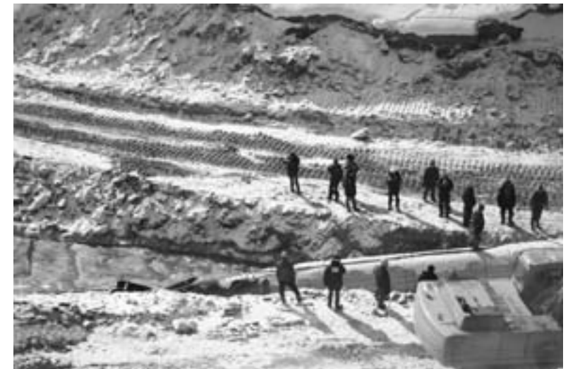
Укладка нефтепровода в траншею на дне реки Лены
